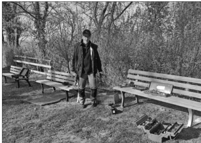
Die sanierten Parkbänke.
