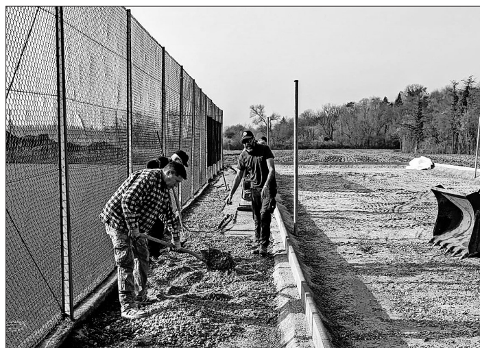
Es bedarf vieler fleißiger Helfer, um ein Projekt wie das vom Tennisclub Heimbach umzusetzen. Mit Schaufel und Muskelkraft waren sie da. Das Ziel ist nahe: Der Beach-Tennisplatz beim TC Heimbach soll in dieser Saison eröffnet werden.
