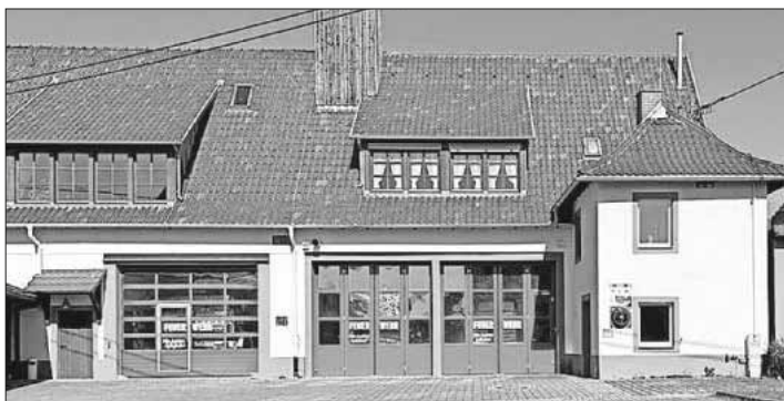
Der zweite AED befindet sich auf der rechten Seite des Feuerwehrgerätehauses in Köndringen.
