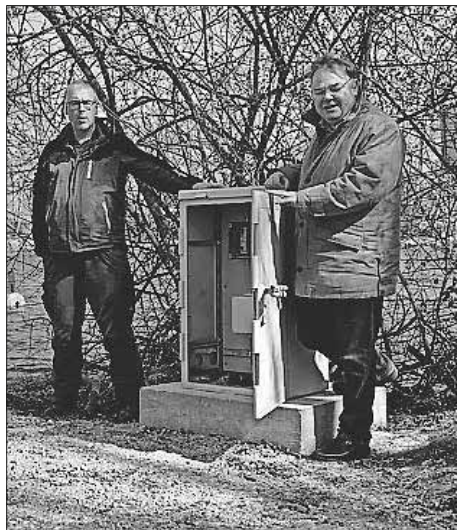
Von links: ASV-Vorstand Uwe Albrecht und Bürgermeister Heinz-Rudolf Hagenacker nach erfolgter Inbetriebnahme.
