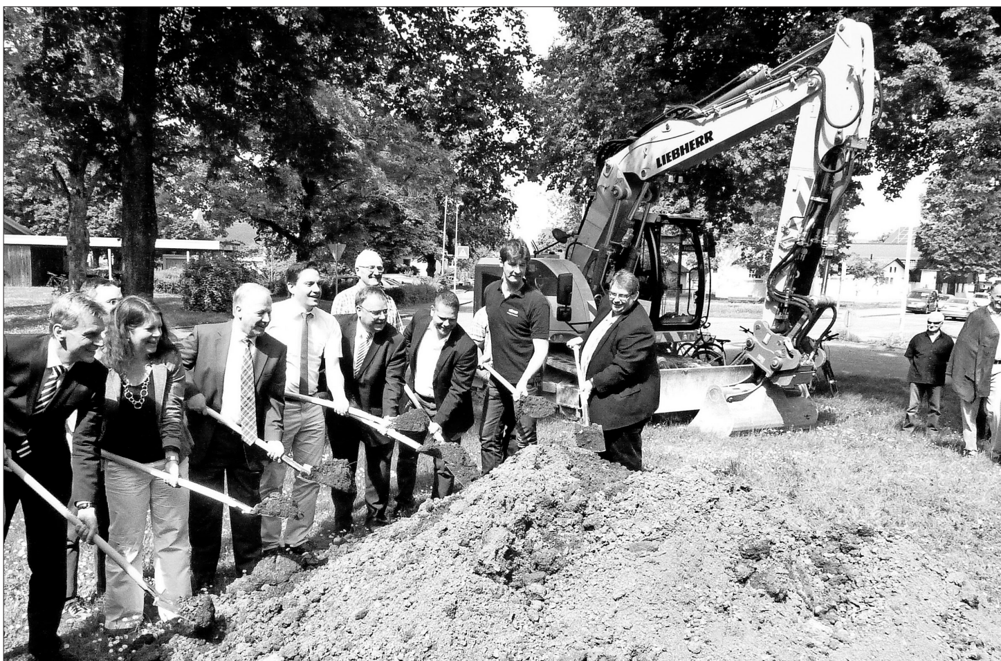
Viel zustimmendes Interesse war beim Spatenstich für die Nahwärmeversorgung deutlich.
